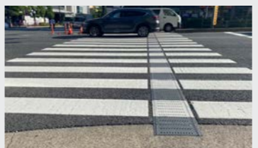
黄色にはなっていないが、横断歩道にも点字ブロックが実装されている。
