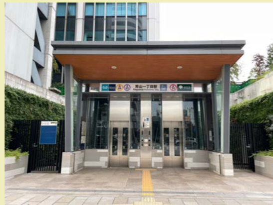
大型のエレベーターが新設された青山一丁目駅。
